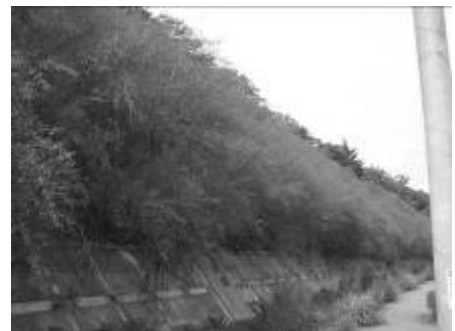
図2. ヤマハギを用いた法面 (常磐バイパス 9月撮影)
