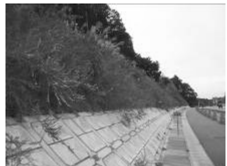
図3. メドハギを用いた法面 (平バイパス 9月撮影)
