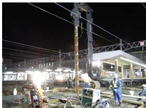
写真-1 鋼管杭打設状況
