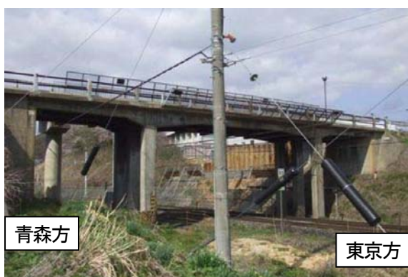
写真-1 既設こ線橋全景
