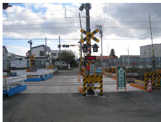
写真-1 石江踏切全景
