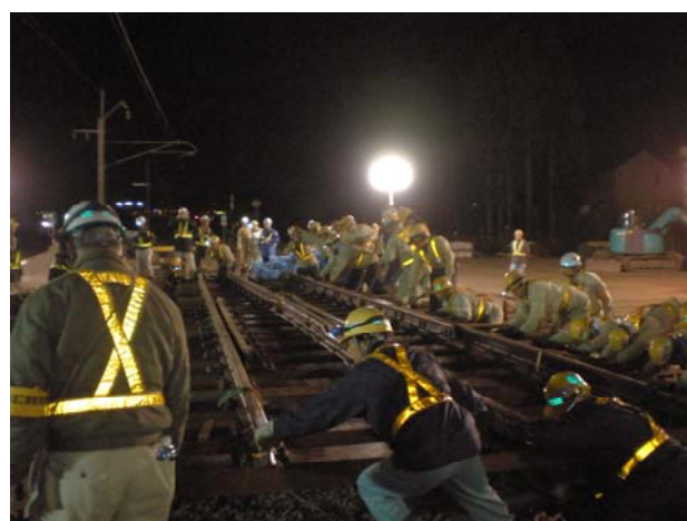
図 7 施工状況(クロッシング部)
