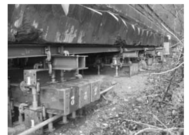
ベント設置状況
