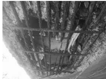
桁損傷状況
