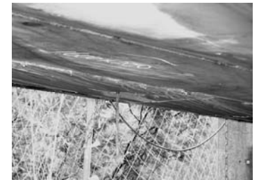
桁内水抜き状況
