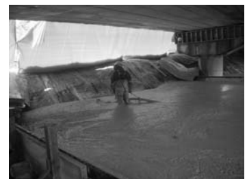
FCB 打設状況
