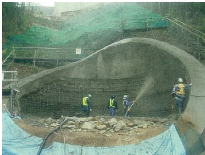
写真-3 吹付けコンクリート壁施工状況
