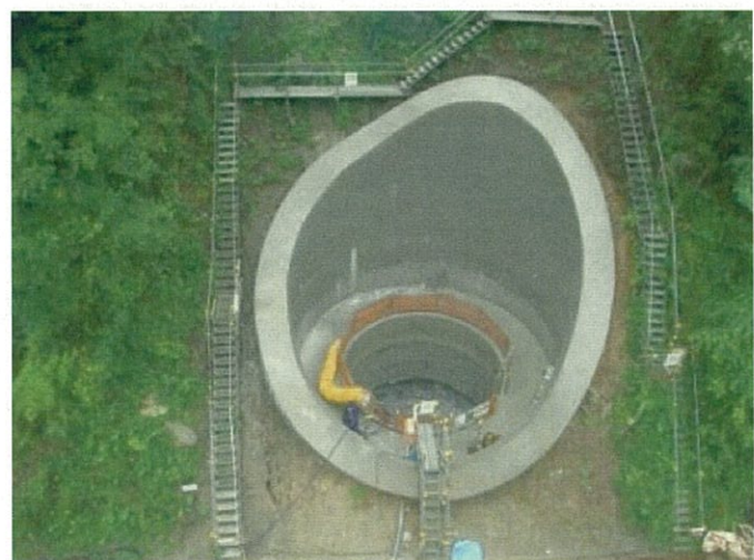
写真-4 施工完了状況
