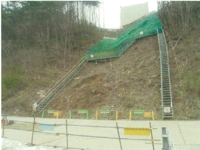
写真-1 施工前状況
