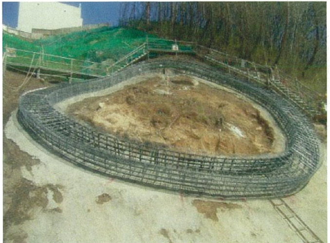
写真-2 リングビーム配筋状況
