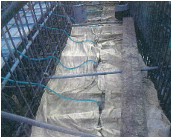
写真 2. 側壁のパイプクーリング状況
