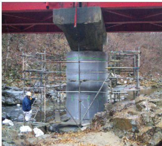
写真 1. RC 巻立て Co 養生状況
