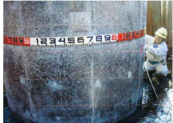
写真 3. 橋脚補強の脱型直後のコンクリート表面
