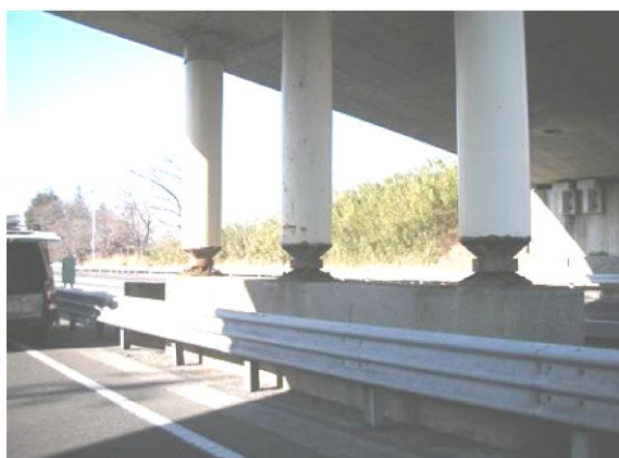
写真 2 ロッキング式橋脚(B 橋)
