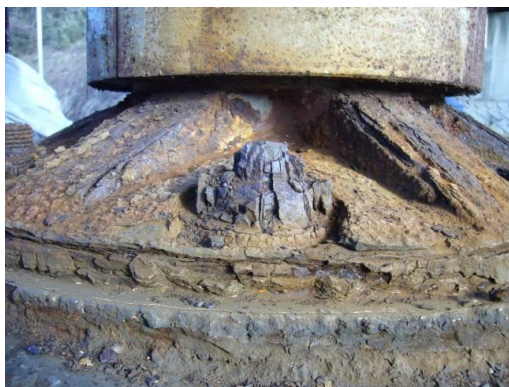
写真3 カバー撤去後の橋脚下部支承(B橋)
