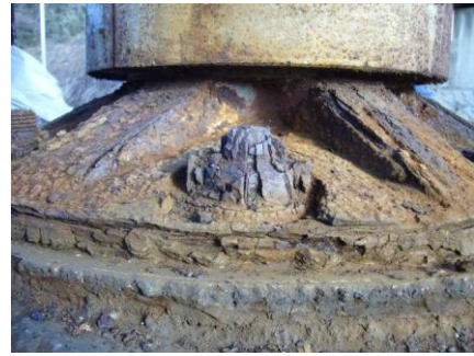
写真2 カバー撤去後の橋脚下部支承(B橋)
