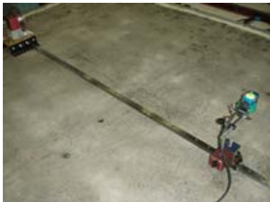
写真-1 スケーリング深さ測定
