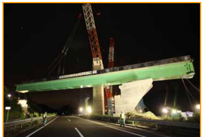
図6 Cランプ橋の桁を落とし込む状況 (一括架設総重量; 約260t、作業半径; 最大31m)
