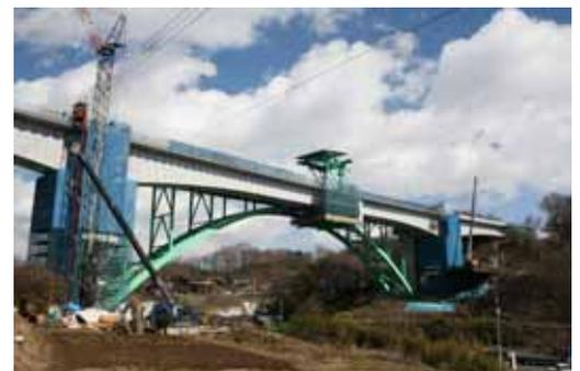
写真-1 水平反力調整工実施状況写真
