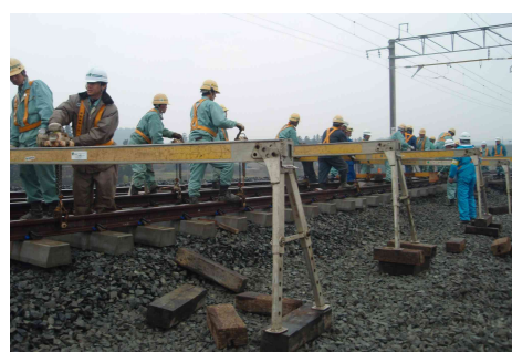
写真 - 1 軌きょう横移動施工状況
