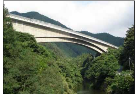
写真1 八幡平橋（中央径間部）
