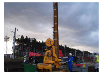
写真-2 増強ウォータージェット併用油圧圧入工法（案 2）
