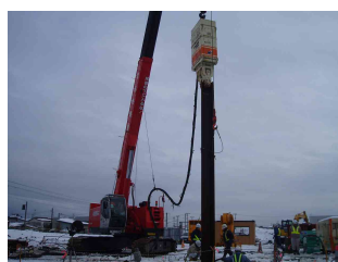
写真-1 ウォータージェット併用油圧パイプロ工法（案 1）
