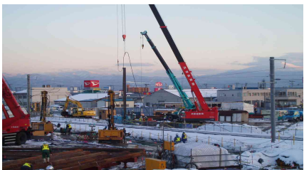
写真-3 工事現況（2009.1 現在）
