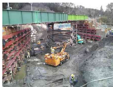
写真-2 線路下掘削後状況
