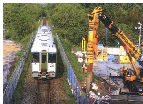
写真 - 5 スカット工法
