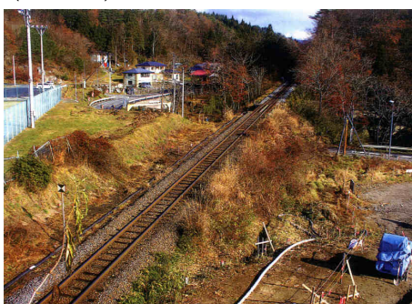
写真-1 施工前状況
