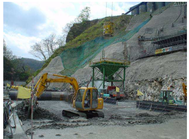
写真-4 打設全景
