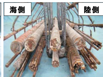
写真-2 第 2 径間 0502 下フランジ部 鋼材写真
