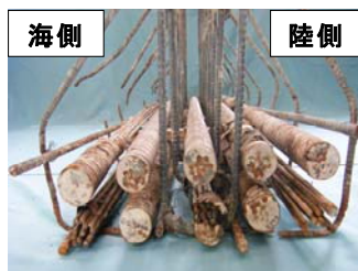
写真-1 第 2 径間 0403 下フランジ部 鋼材写真
