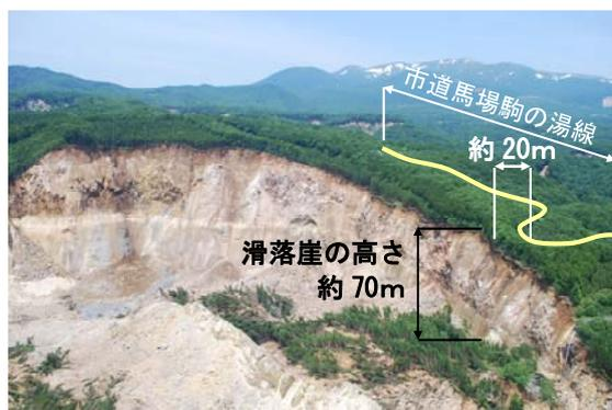
写真-1 荒砥沢ダム上流地すべりの滑落崖<sup>2)</sup>
