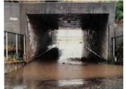
写真-1 C-BOXの沈下による滞水
