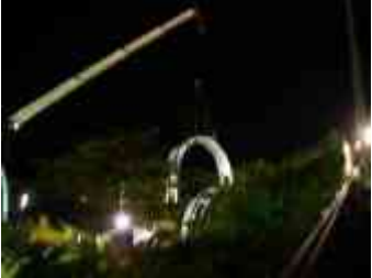
写真 - 4 緩衝工設置
