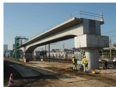
写真-1. PRCT ラーメン高架橋
