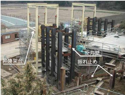
図-6 けん引反力設備（側壁エレメント到達側）
