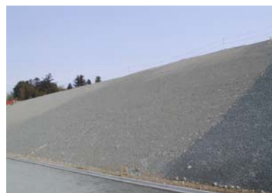
写真－2 購入材による法面試験施工状況
