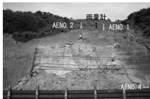
図4 法面の設置状況 (全景)
