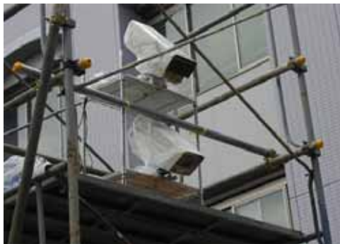
図1 枠組足場上カメラ設置状況
