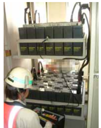
写真-1 蓄電池設備(56セル)
