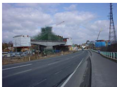
写真－1 張り出し架設
