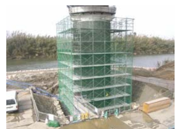
写真-2 施工状況
