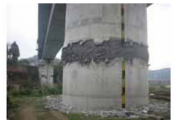
写真-1 段落し部の損傷例
