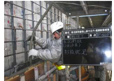
写真-3 コンクリート打設状況
