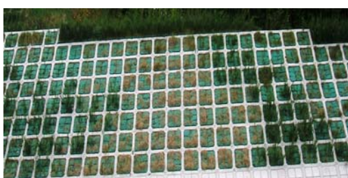
図 3 法面の状況（10 月）
