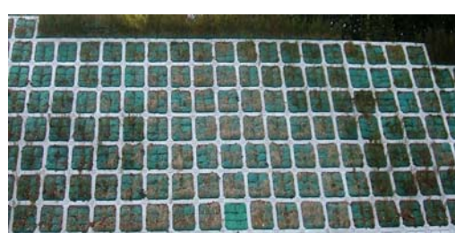
図 4 法面の状況（12 月）
