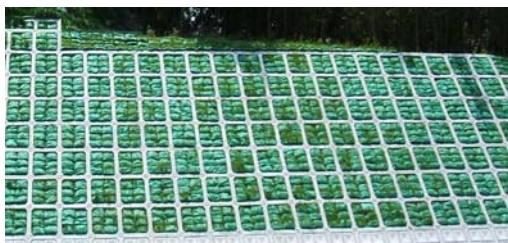
図 1 法面の状況（6 月）
