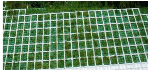
図 2 法面の状況（8 月）
