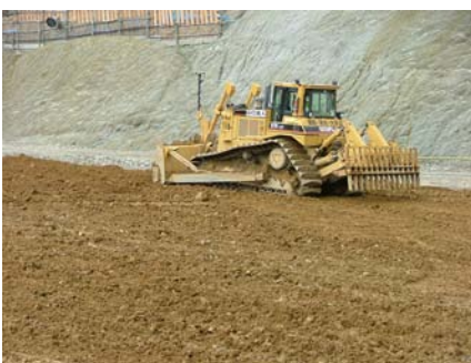
写真-1 3D-MC ブルドーザー
