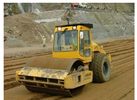
写真-3 振動ローラー
