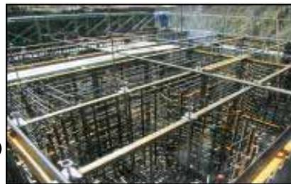
写真 4 鉄筋架台
