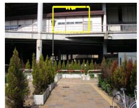
写真-1 高架橋接続現況写真
