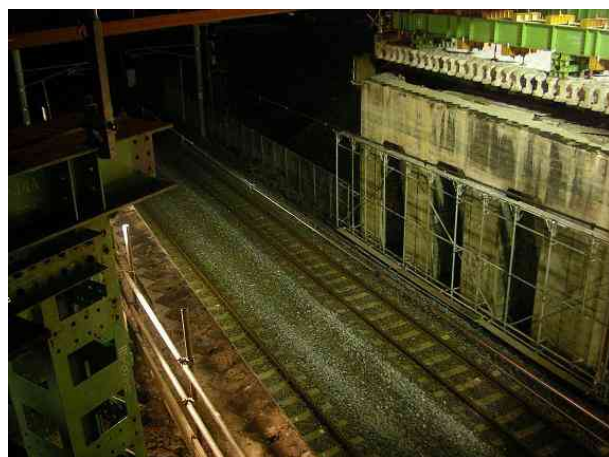
写真-5 既設桁撤去後状況
