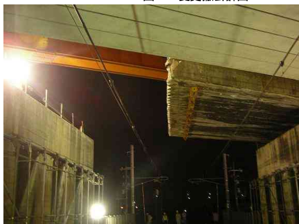
写真-4 撤去縦取り状況
