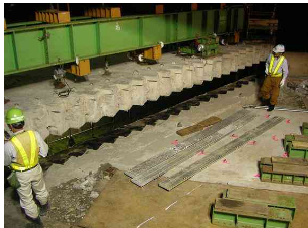
写真-3 撤去桁ジャッキアップ状況
