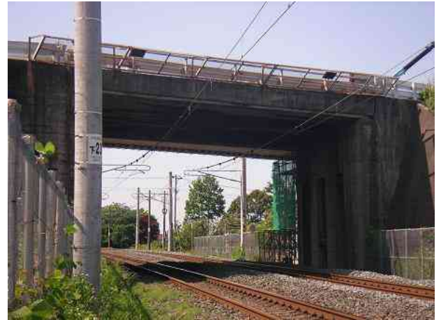
写真-1 既設撤去桁全景
