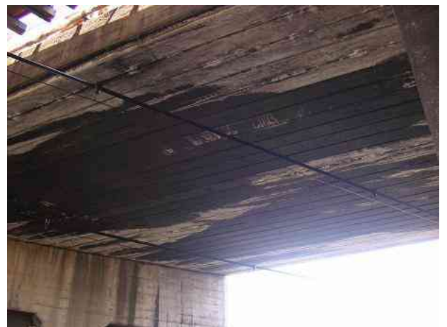
写真-2 既設撤去桁下面
