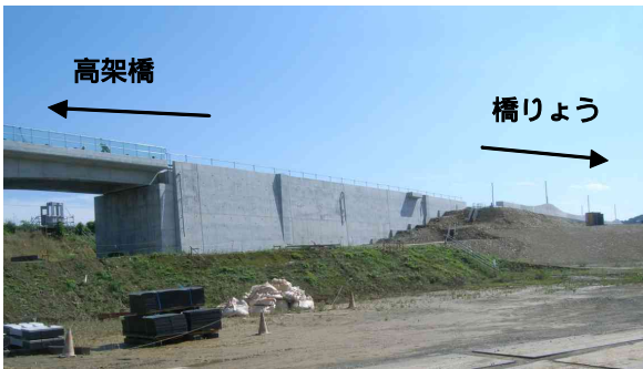
写真-2 RRR 完成全景写真（北部側）
