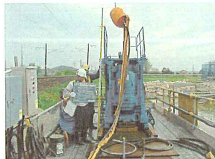
図-4 Sj-m 施工状況
