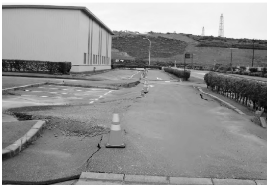
写真-1 新潟県中越沖地震（刈羽原発内部）の断層被害例
