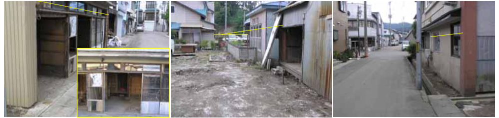
写真-3 浸水痕跡例(左: 浸水位 0.05m, 浸水深 2.05m, 中: 0.12m, 2.16m, 右: 0.29m, 2.08m)
