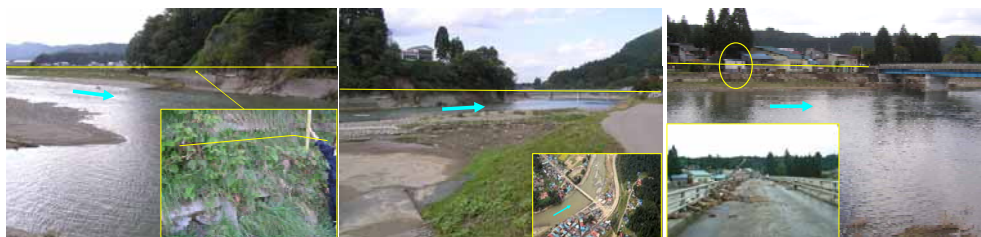
写真-2 左岸上流から下流の八幡橋にかけての浸水痕跡（図中の実線）
