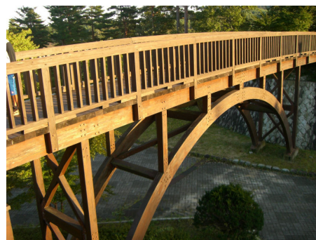
写真-1 思惟公園内2号橋全景写真
