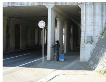
写真 1 実構造物（幅 1.7m）
