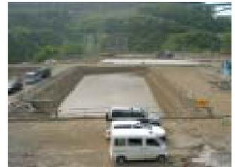
写真2 濁水処理設備の沈砂池
