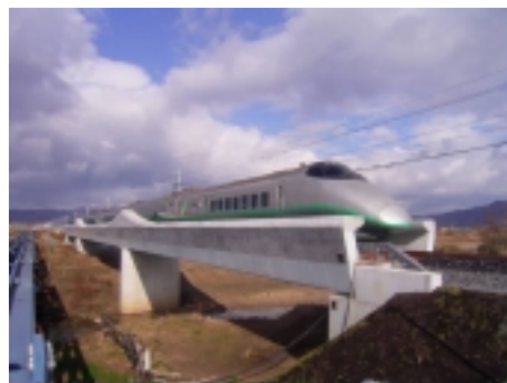
写真1 完成後の第一吉野川橋りょう
