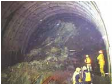
写真 2 崩落状況
