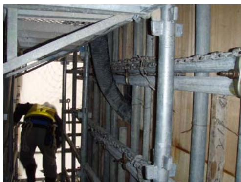
写真-2 打設口からの打設状況
