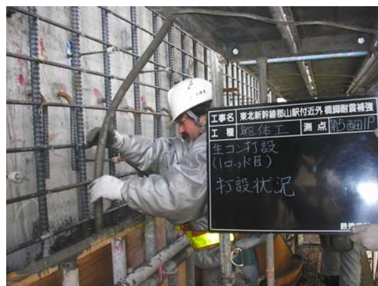
写真-1 コンクリート打設状況
