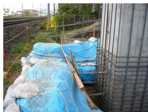
写真-3 地中部施工時の状況
