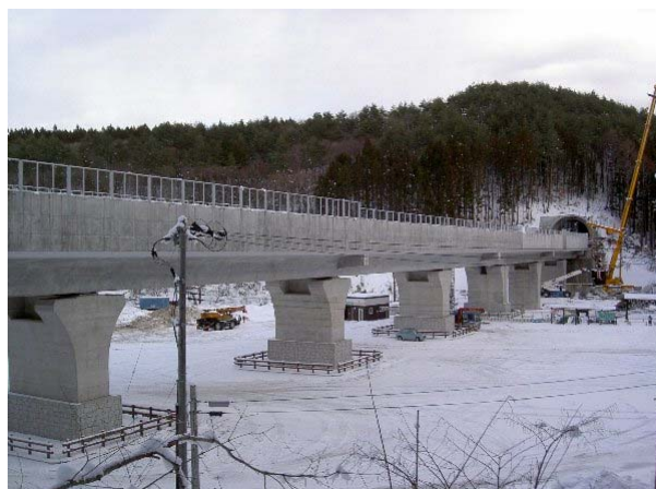
写真—1 ねぶたの里高架橋全景
