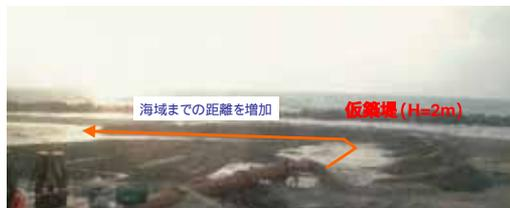
写真 3 . 排砂管前面の仮築堤
