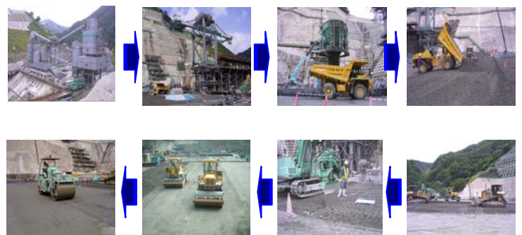
（図-2 長井ダム R C D 工法の流れ）
