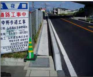
図-6（側溝蓋設置）
