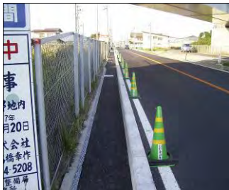
図-7（舗装仕上げ：完成）
