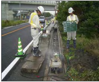
図-5（カッター切断）
