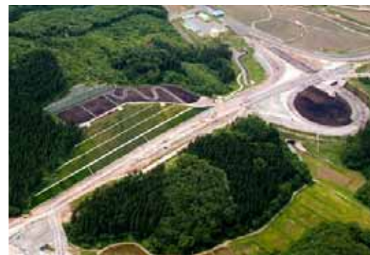
写真-1 地すべり対策後の航空写
